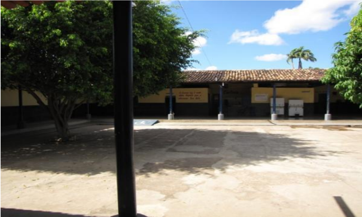
Figura 09: Visão interna da Unidade Escolar Landri Sales
